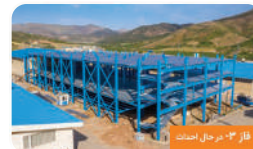
فاز ۳ - در حال احداث
