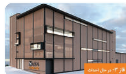
فاز ۳ - در حال احداث
